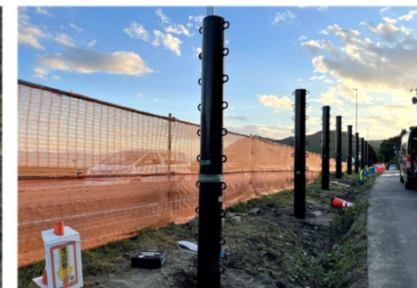
支柱設置状況
