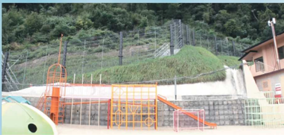
1mを超える巨大な落石にも対応可能とされる、画期的な「落石防護フェンス」。耐久テストと幼稚園の前に設置される現場を取材。業界の常識を覆す技術とは？
