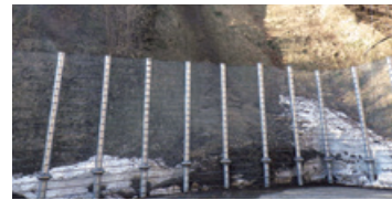
土砂捕捉状況
