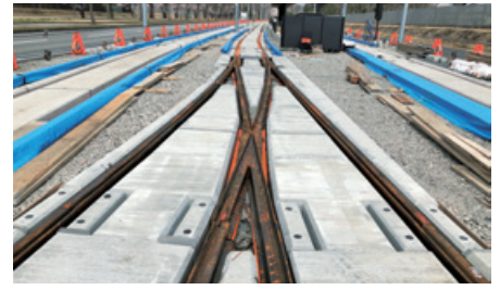
レール敷設後
