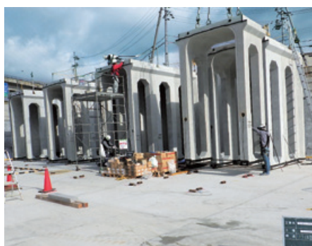
門型部材施工中
