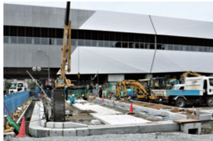
小松駅前 施工中
