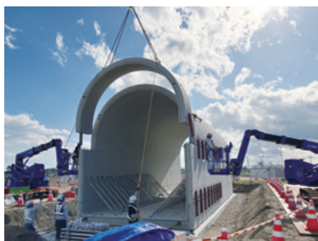
施工組立状況
