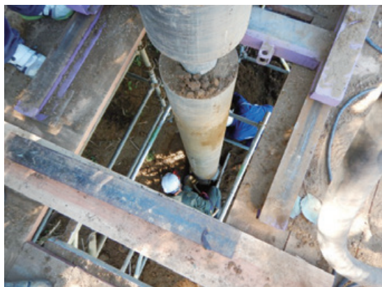
支柱部施工状況
