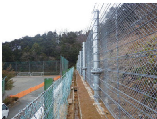
完成（校庭区間）
