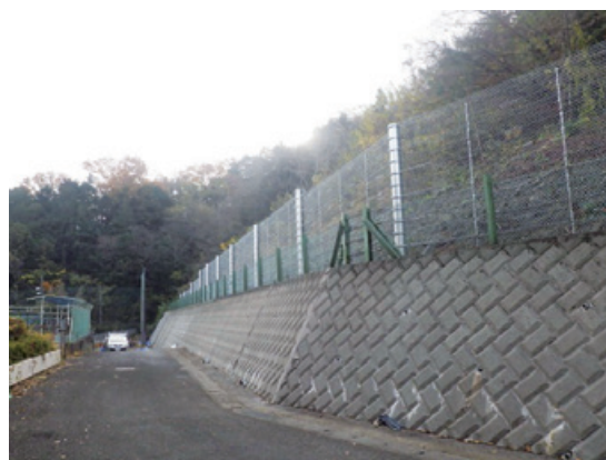
完成（道路区間）
