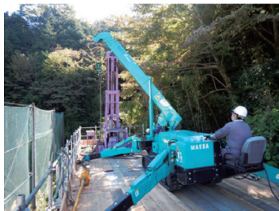
フェンス部施工状況
