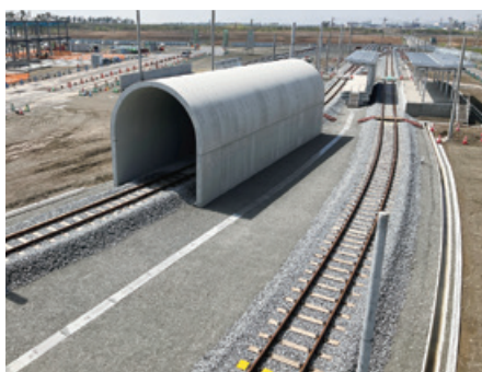
トンネル構造（左手前）
