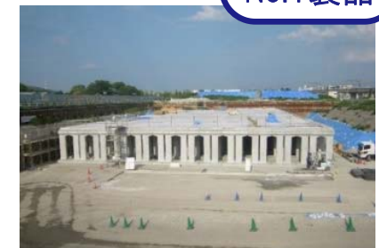
地下 雨水貯留施設
