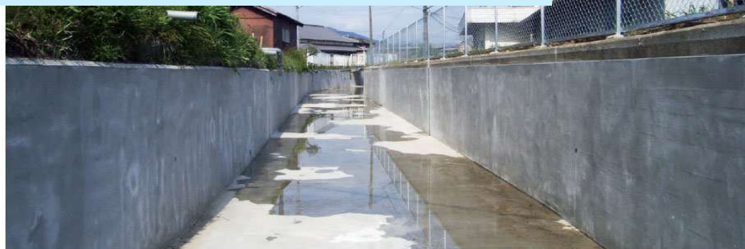
ASモルタル工法
