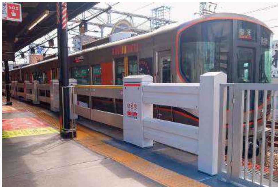
改良型可動式ホーム柵 JR西日本・(株)JR西日本テクシア・ナブテスコ(株)共同開発
