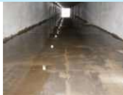
ダクトアルパネルライニング工法
