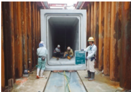
施工状況（エアーキャスター工法）
