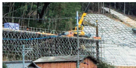
作業台設置状況
