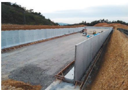
施工中 全景（2号調整池）
