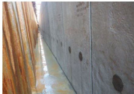
施工中（埋戻し前の片側延長状況）
