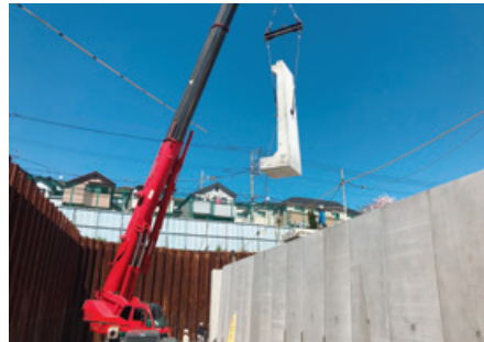
側壁部材組立状況
