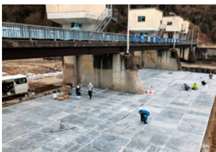
ダクトパネル施工中 全景
