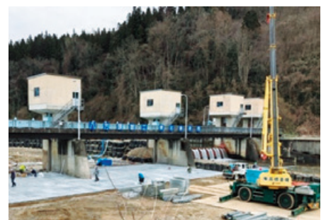
八方頭首工 全景
