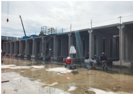
地表面下約7m 設置状況
