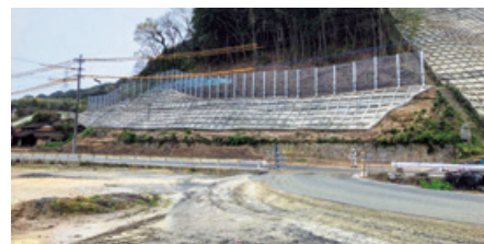
全景（赤谷川側より）
