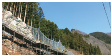
施工中（足場設置状況）
