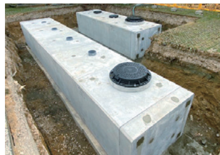
据付完了 指定避難所 (2槽・8穴・400人想定)
