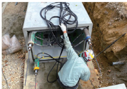
セラピット施工中
