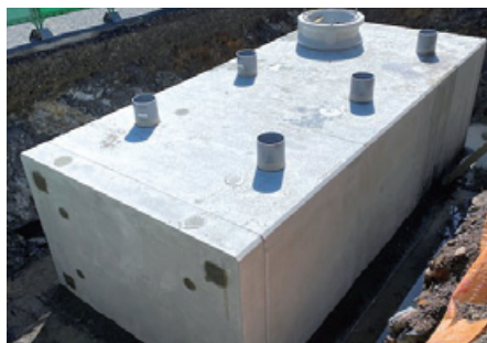
据付完了 道の駅 (5穴・295人想定)
