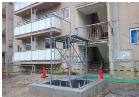
施工前 基礎部分
