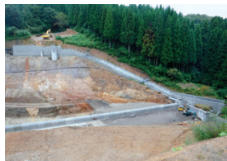
施工完了(埋戻し前)
