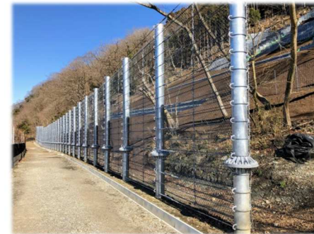
ループフェンス施工実績
