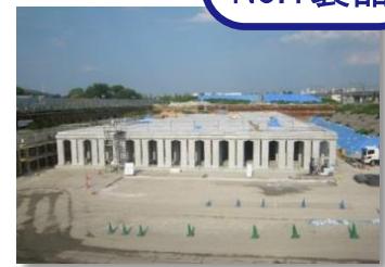
地下 雨水貯留施設
