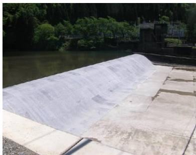
(高強度繊維コンクリートパネルによるライニング施工後)
