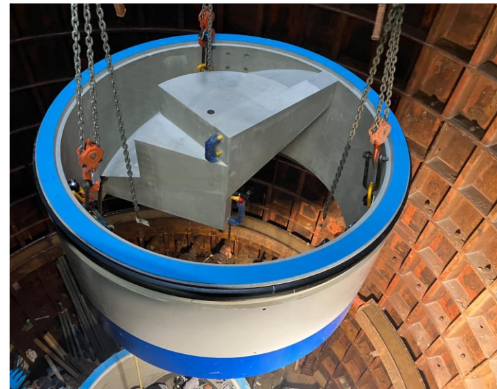
製品据付状況
