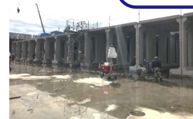
地下雨水貯留施設
