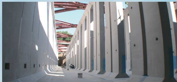
工場で製作した部材を現場で組み立てるプレキャスト化により工期を短縮。ゲリラ豪雨にも対応する特殊バルブを搭載し機能をアップ、進化した「貯留施設」。
