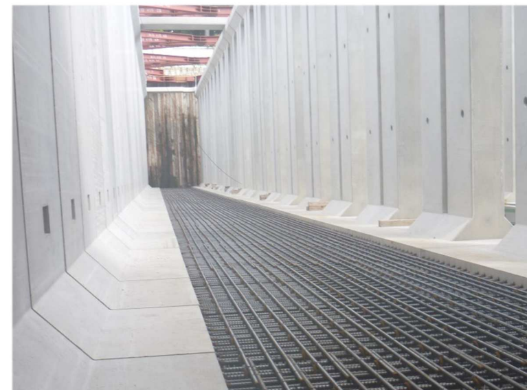
製品据付状況
