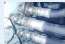
プレス機械の動力接続
