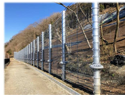
ループフェンス施工実績
