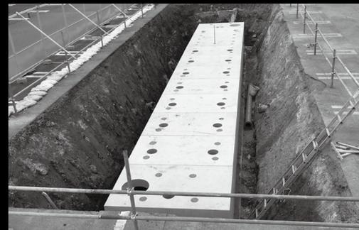
ベルテクス株式会社では、災害時にすべての人が安心して使える「非常用トイレ」を目指し、四つのタイプのトイレシステムを展開している。江戸川区が採用した雨水貯留槽式災害用トイレ「レスキュート」は、雨水を貯留する貯留槽と便槽が一体となった構造で、貯留した雨水を使って排泄物を下水道に流すことができる。
