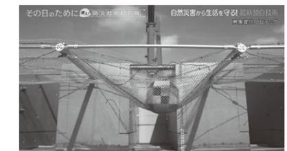
変形することで柔軟にエネルギーを吸収し、落石を受け止めるよう設計されている。
