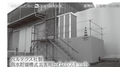
レスキュートはコンクリートの箱の上に簡易トイレを組み立てて使用する。
